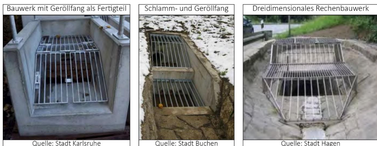
Abb. 11: Beispielhafte Verbesserung von Einlaufbauwerken an Gräben und vor Verrohrungen
