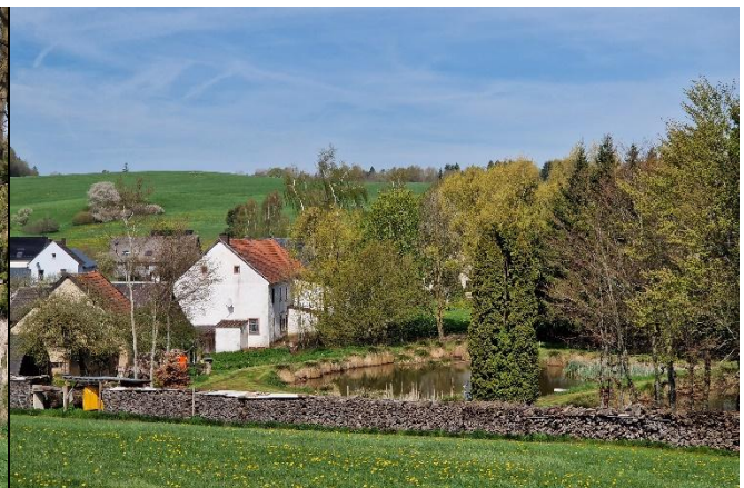
Unterer Weiher vor Bachverrohrung
