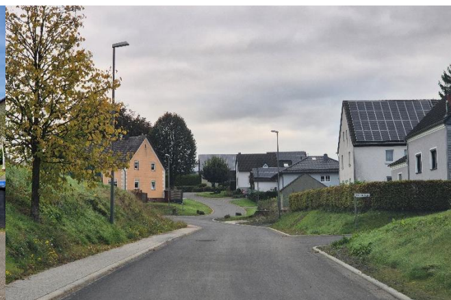
Zustand nach der Erneuerung (Blick gg. die Fließrichtung)
