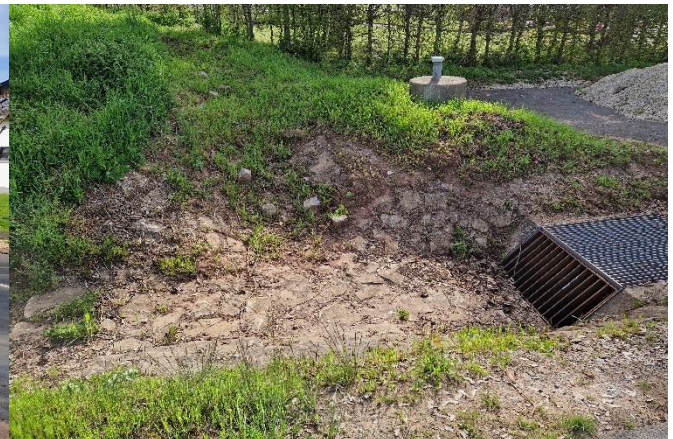
Einlassbauwerk an der K 72 neben dem Friedhof
