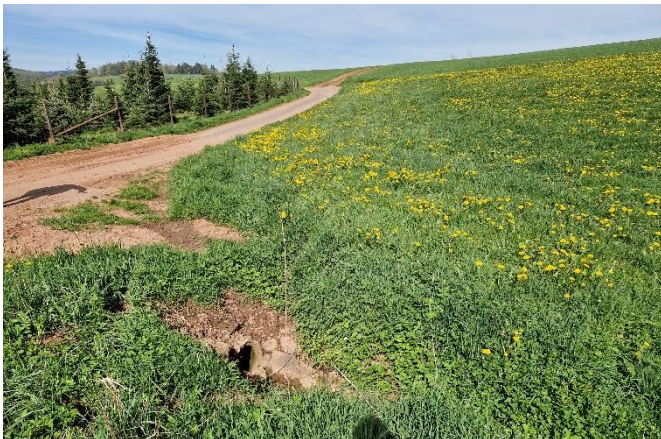
Blick in Fließrichtung auf den Einlass
