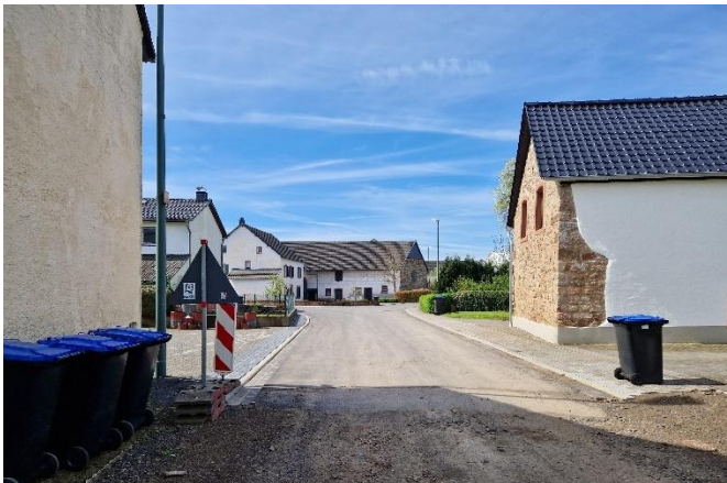
Dorfstraße: Blick zum Tiefpunkt in der Ortsmitte
