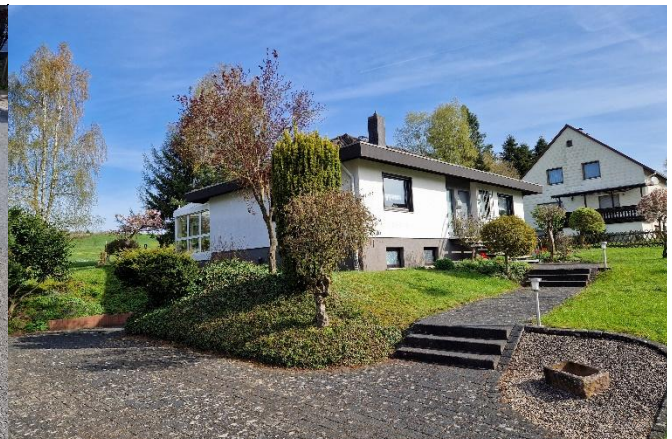
Betroffenes Objekt Nr. 19 mit Tiefgarage
