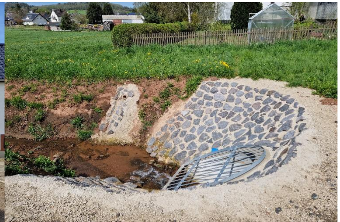
Auslass der Bachverrohrung
