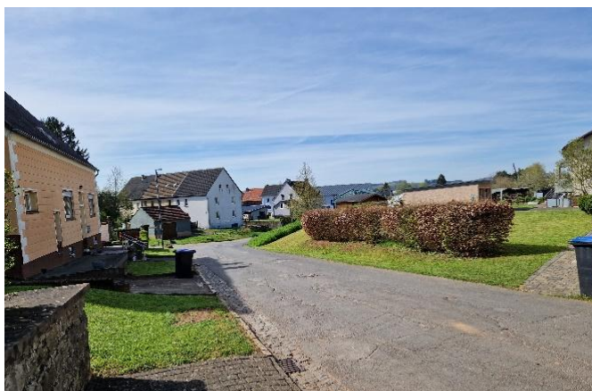
Dorfstraße vor dem Ausbau im oberen Abschnitt
